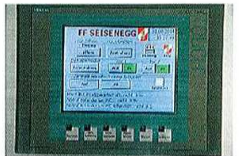
Steuerung der Gebäudetechnik
