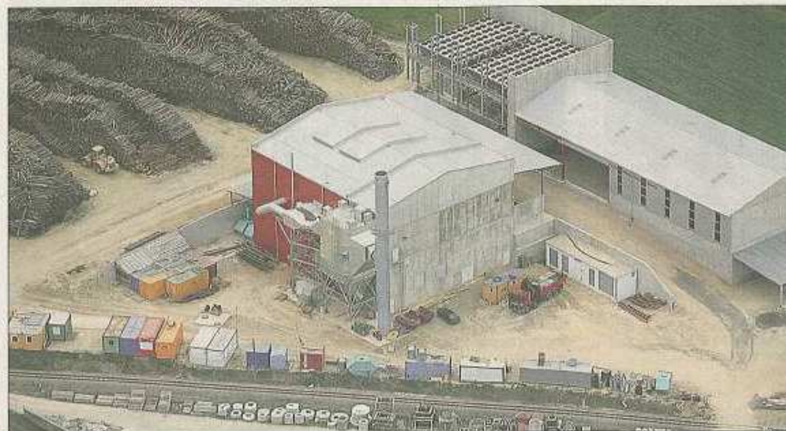
Gleich hinter dem Betonwerk Seidl in Altweitra erstreckt sich das Areal des NAWARO-Biomasse-Kraftwerkes. Es soll in den nächsten Wochen in Vollbetrieb gehen und Strom ins örtliche EVN-Netz liefern. FOTO: WALTER STUBNER
